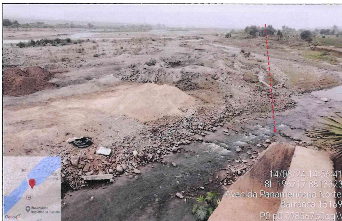
FIGURA N°02: MARGEN IZQUIERDA DEL RIO PATIVILCA EROSIONADO Y CAUCE COLMATADO, DESPROTEGIDO ANTE CRECIDAS DEL RIO EN EL SECTOR PUENTE PATIVILCA, DISTRITO DE BARRANCA, PROVINCIA DE BARRANCA - DEPARTAMENTO DE LIMA.
